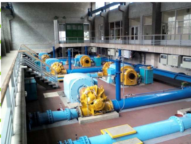
4db 250kW-os kaszkád hajtás Fővárosi Vízművek Zrt. Ráckeve
