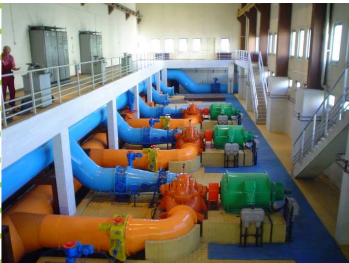
4db 250kW-os kaszkád hajtás Fővárosi Vízművek Zrt. Ráckeve
